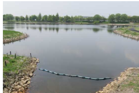
図 2.3 整備後の状況
