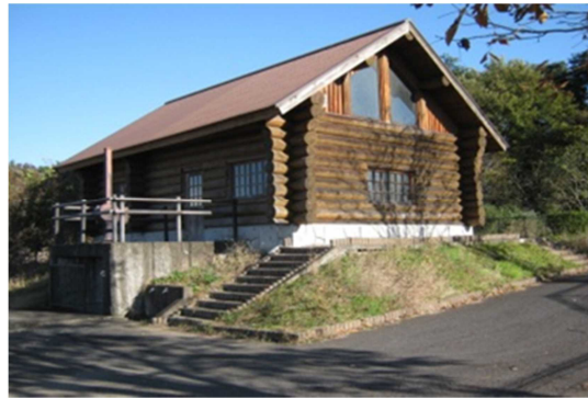
図 4.27 浄化揚水ポンプ場
