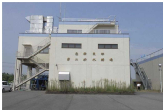
図 4.25 邑楽東部第二排水機場
